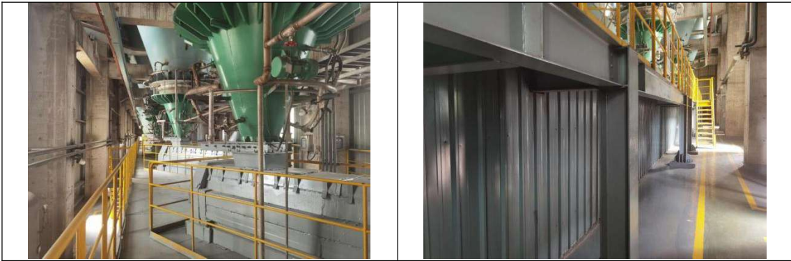
东区烧结配料室
