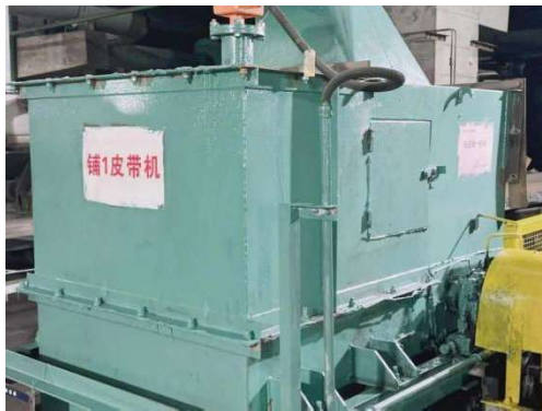
铺_1 皮带落料点
