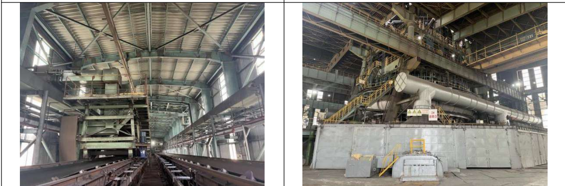
4#高炉矿槽槽上
