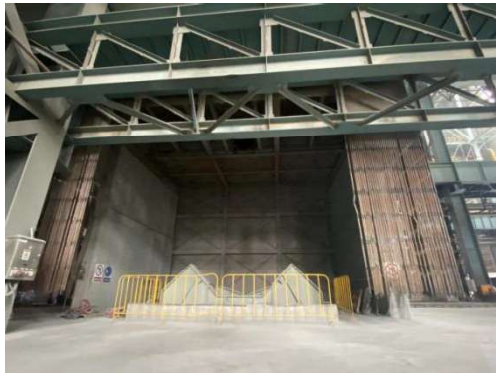
东区炼钢钢包冷修
